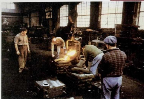
Coulée de la fonte dans un moule sur un chantier. A gauche, Hubert Carteret ; la fonte liquide est transportée depuis le cubilot par un monorail que dirige Athur Detej. Son fils Gilbert manœuvre la poche avec René.
