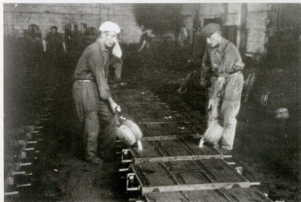
Années 50 : vues de l'ancienne fonderie, avant modernisation des installations. Les moules sont alignés bien à plat sur le sable en attendant la coulée. Pendant longtemps, ce sont les mouleurs eux-mêmes qui effectuent la coulée.
