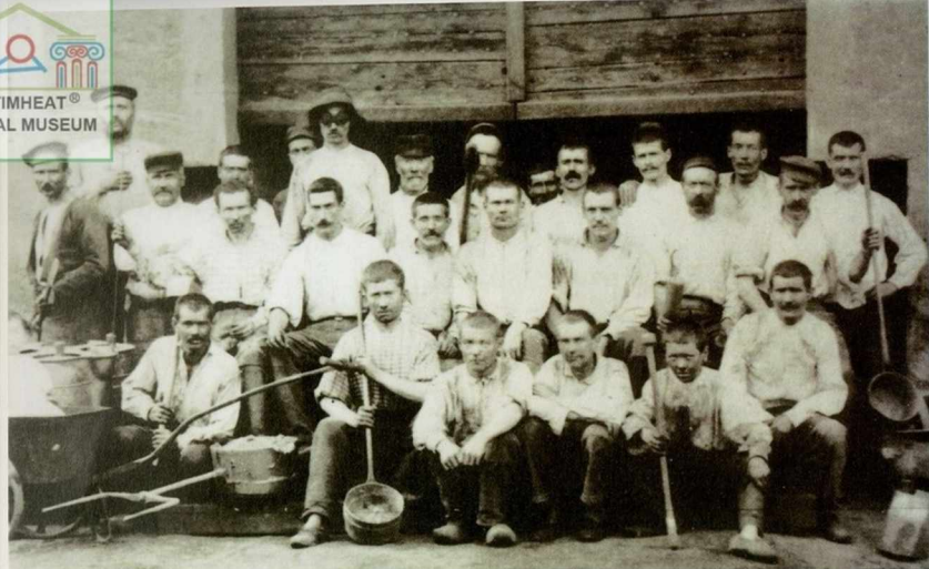
Sans date. Certains mouleurs posent devant la fonderie avec poches de coulée, outil pour tasser le sable. On voit, à gauche, derrière une brouette, la cuve d'un fourneau brute après démoulage.
