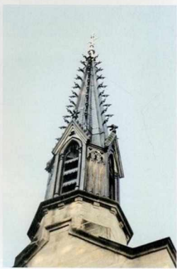
La flèche de la chapelle de Varigney, après restauration.
